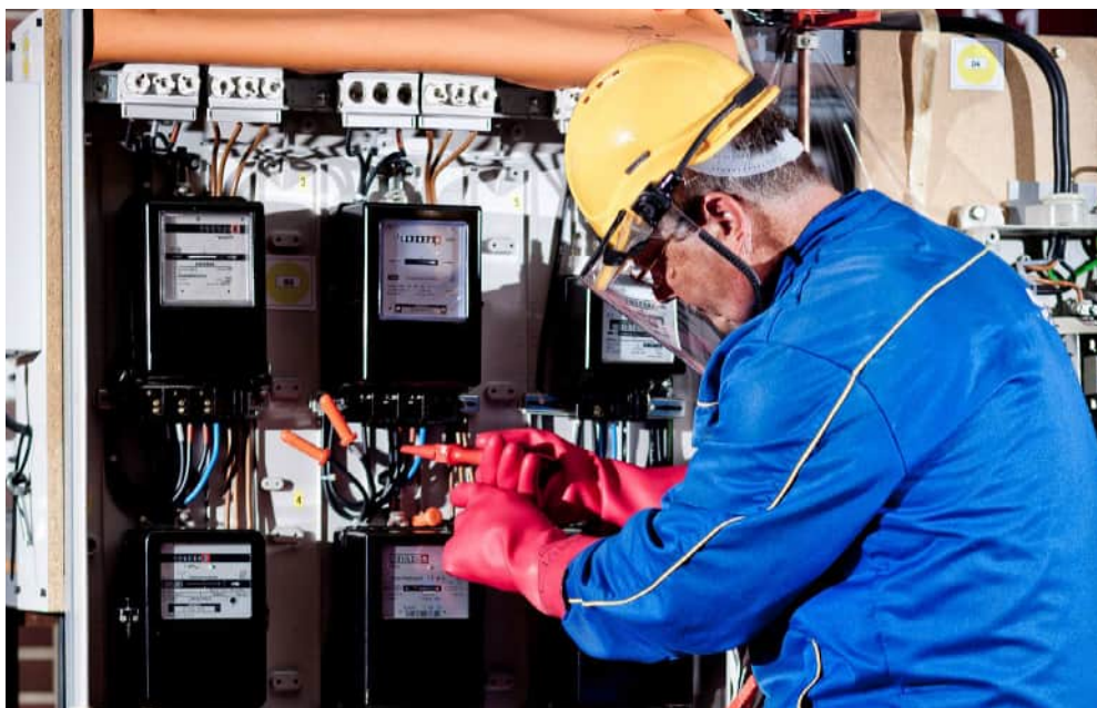
Abb. A 5-10 Arbeiten hinter der Hauseinspeisung
