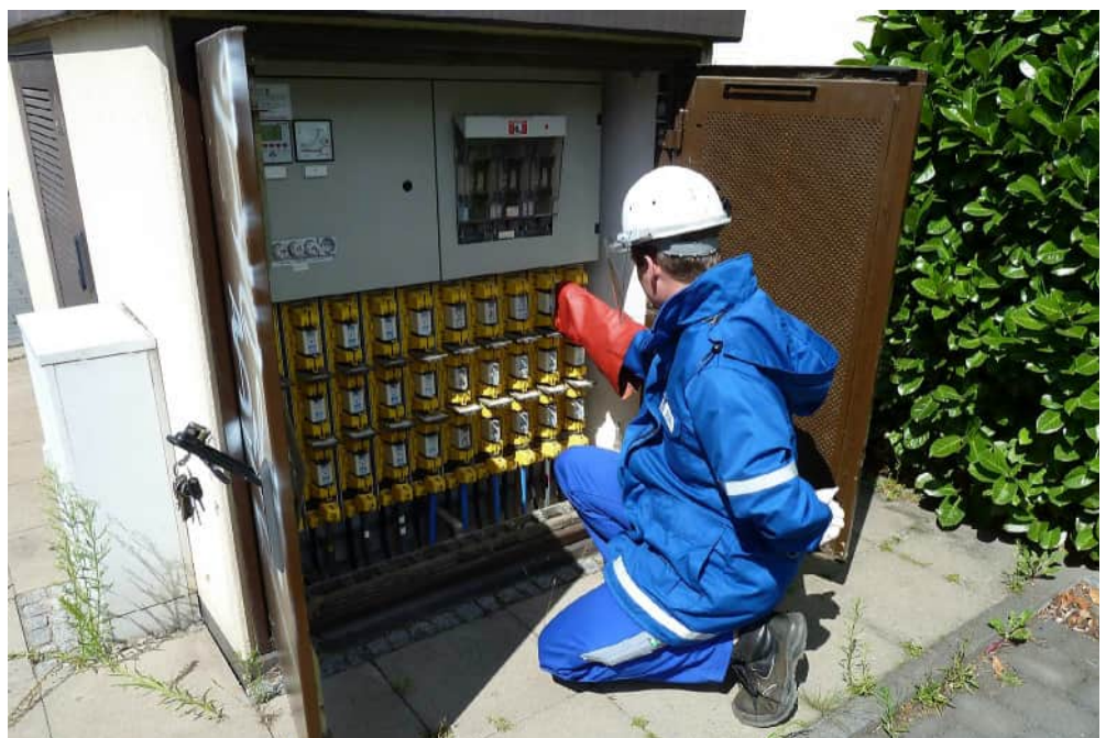
Abb. A 6-4 Arbeiten an einer Kompaktstation: k_T = 1,7
