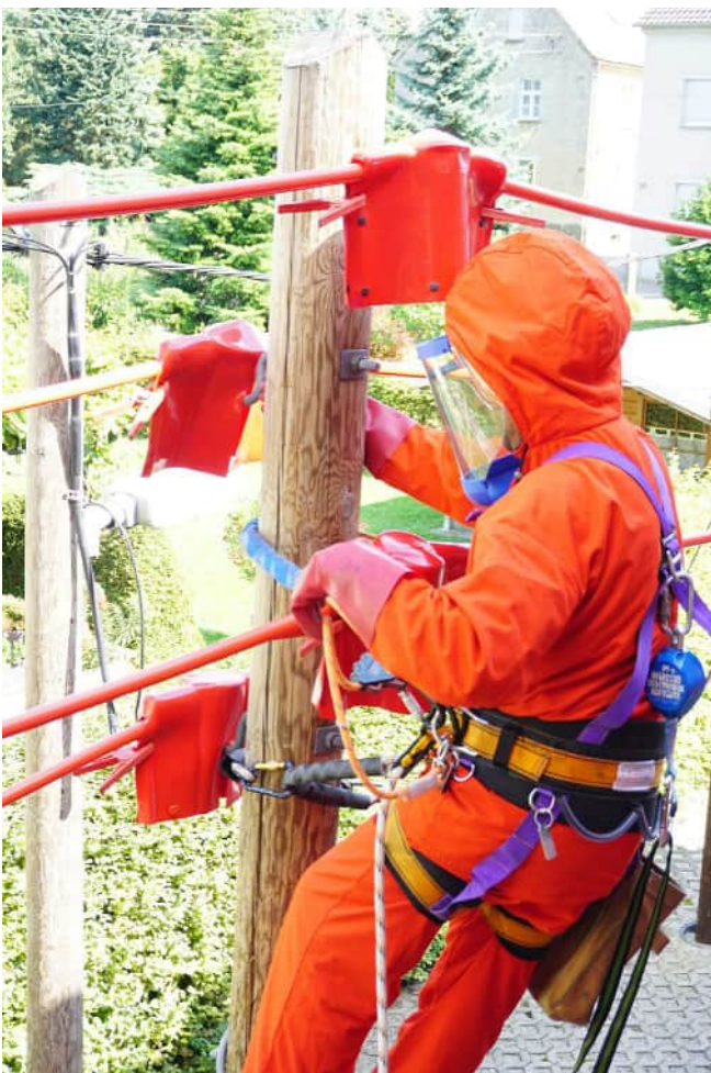
Abb. A 6-6 Arbeiten auf dem Mast: k_T = 2,4
