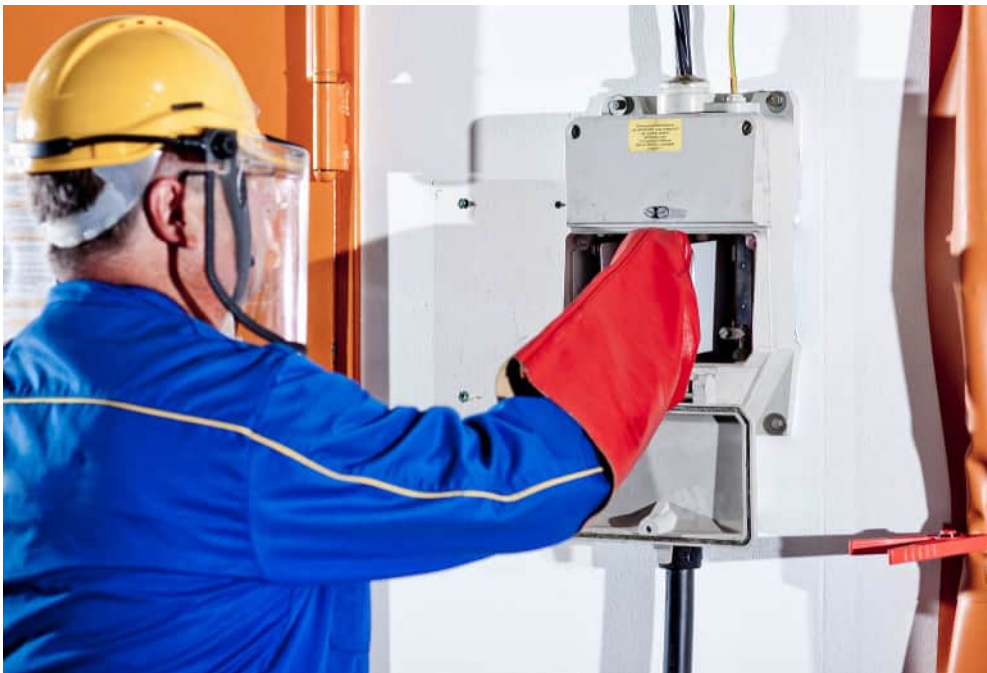
Abb. A 6-1 Arbeiten am Hausanschlusskasten: k_T = 1,0
