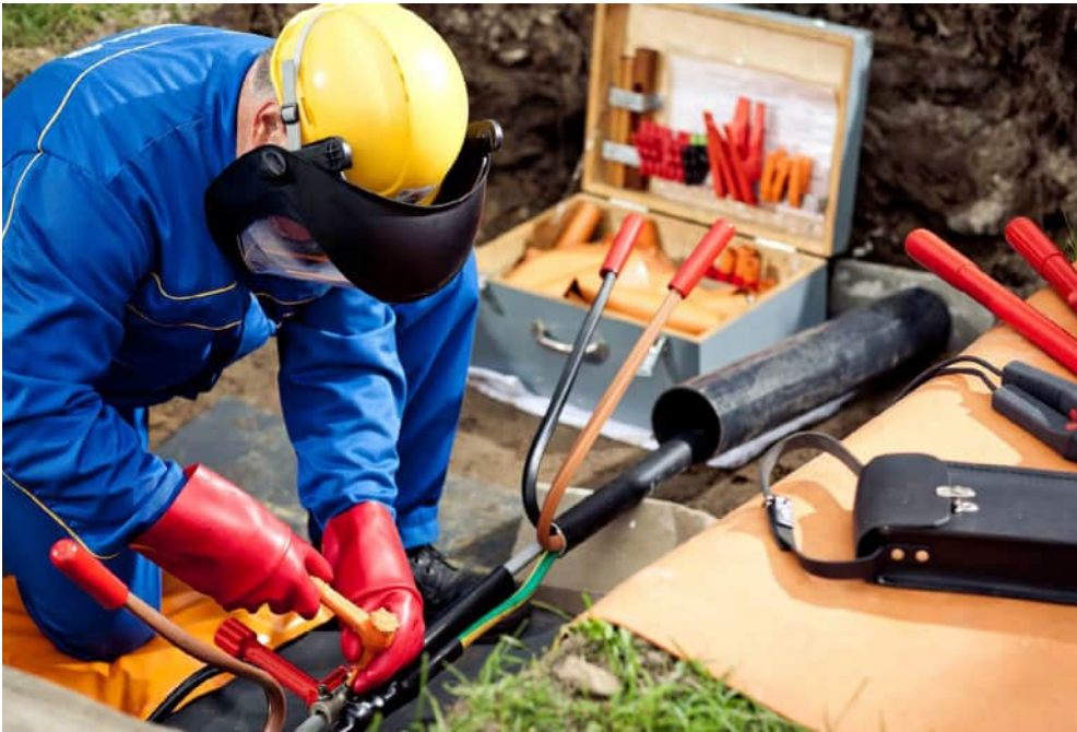
Abb. A 6-5 Muffenmontage: k_T = 1,9
