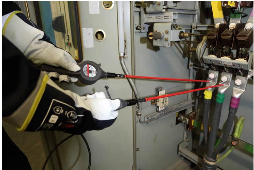
Abb. A 5-22 Feststellen der Spannungsfreiheit
