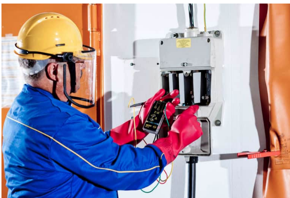
Abb. A 5-8 Arbeiten am Hausanschlusskasten
