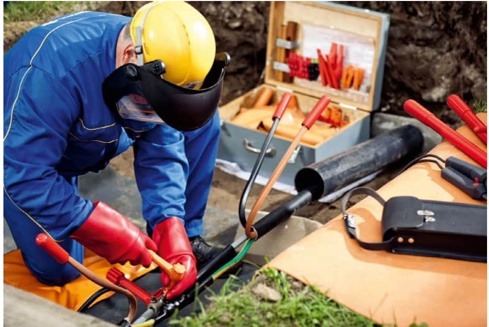
Abb. A 5-6 Arbeiten an einer Kabelmuffe
